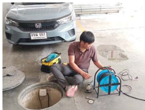
เจ้าหน้าที่ตรวจเช็ค และซ่อมบำรุงระบบบำบัดน้ำเสีย
